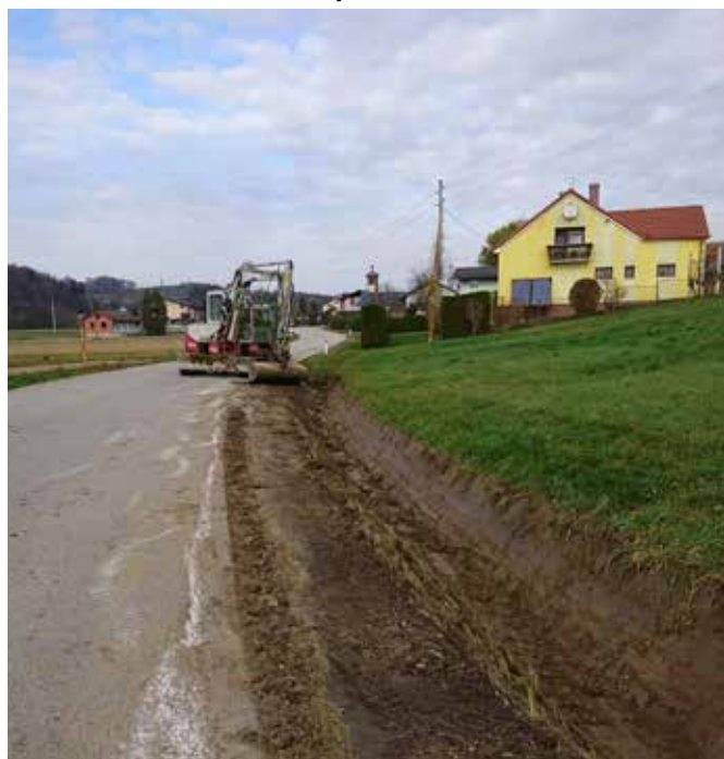
Izkop jarka ob občinski cesti (Foto: M. Žokš)
