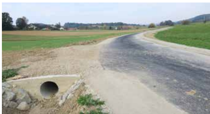
Po izvedbi; nova asfaltna cesta (Foto: M. Žokš)
