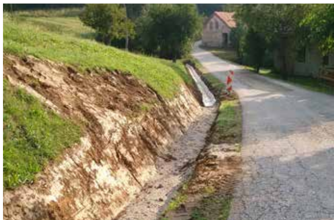
Hkrati je potekala ureditev odvodnjavanja (kanalete, propusti, mulde). (Foto: M. Žokš)
