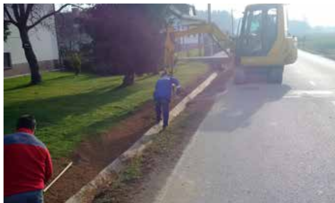
Položitev kanalet ob občinski cesti (Foto: M. Žökš)
