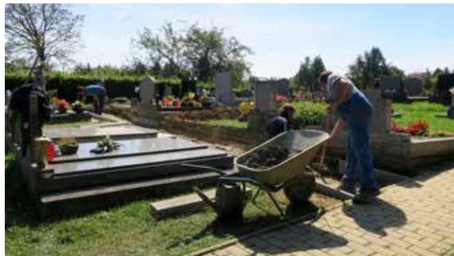
Izkop, položitev robnikov, navoz, plošče (Foto: M. Žokš)
