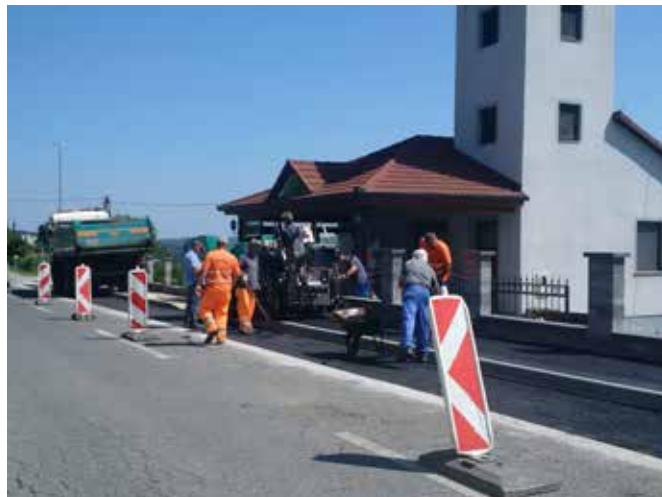
Asfalterška dela (Foto: M. Žokš)
