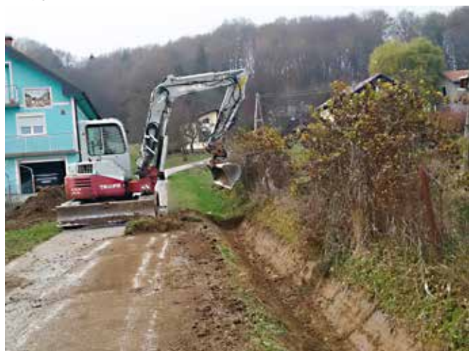
Izkop proti Fujsu (Foto: M. Žokš)
