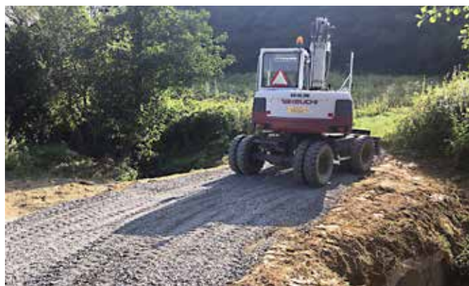
Sanacija mostu (Foto: M. Žokš)
