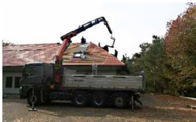
Obnova ostrešja na lovskem domu v Kuzmi (Foto: Arhiv LD Grad-Kuzma)
