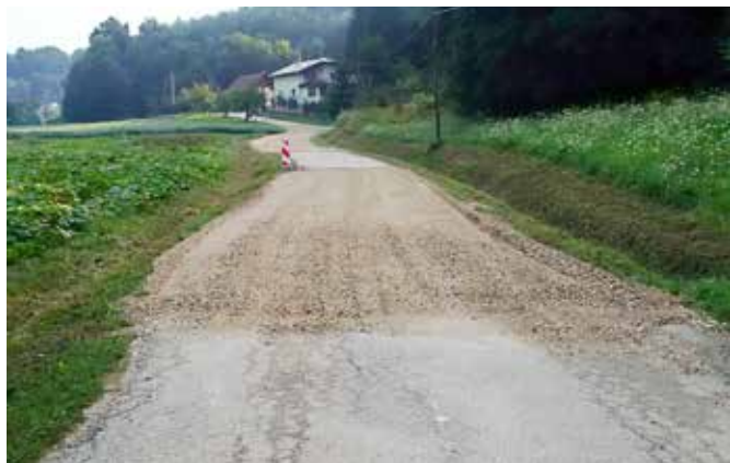
Začetek sanacije (Foto: M. Žokš)
