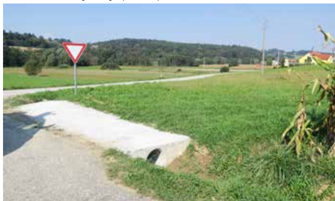
Uredilo se je več novih propustov. (Foto: M. Žökš)
