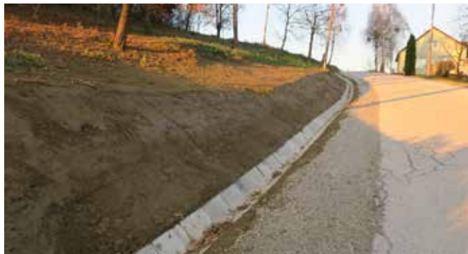
Položitev kanalet in ureditev plazovite brežine
