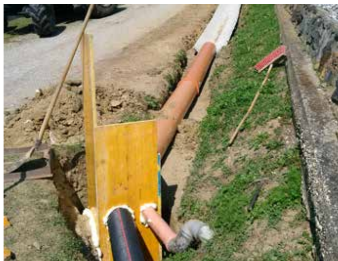
In izdelava revizijskega jaška (Foto: M. Žökš)
