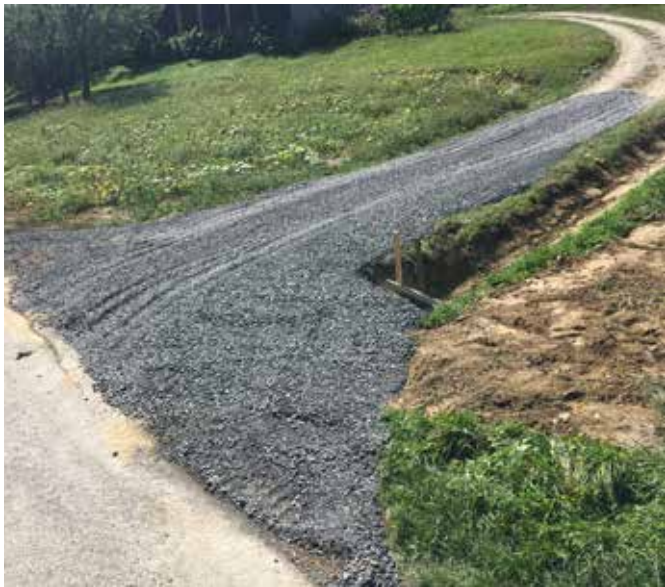
Izkop jarkov in popravilo poškodovanih propustov (Foto: M. Žokš)
