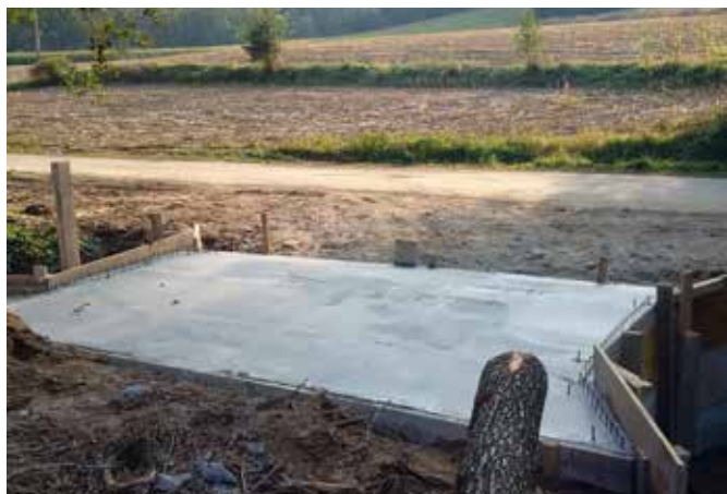
Izgradnja novega mostu - Smodišove njive (Foto: M. Žokš)
