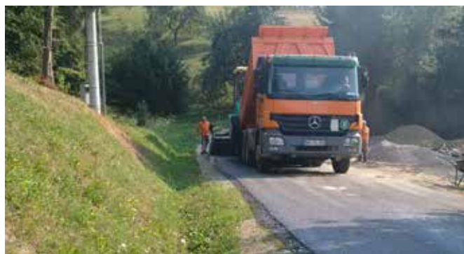
Asfalterska dela (Foto: M. Žokš)
