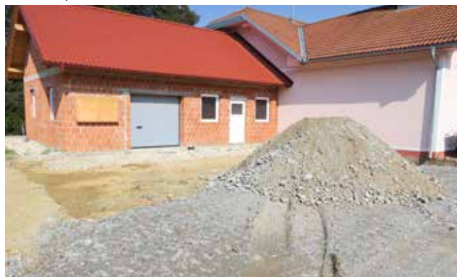
Delo pri gasilskem domu – priprava za asfaltiranje (Foto: M. Žökš)
