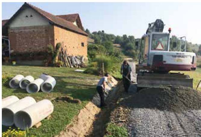
Urejanje odvodnjavanja pri Vrečičevih (Foto: M. Žokš)
