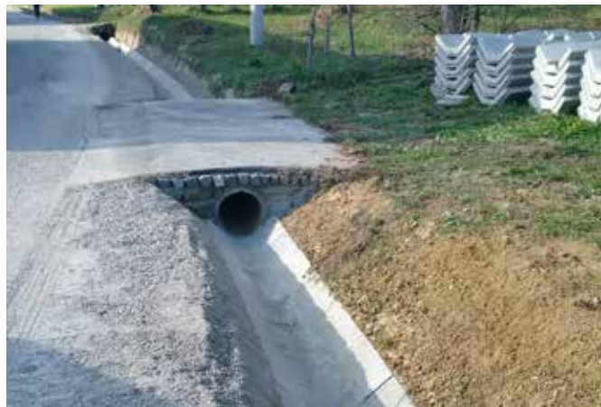
Polaganje kanalet (Foto: M. Žokš)
