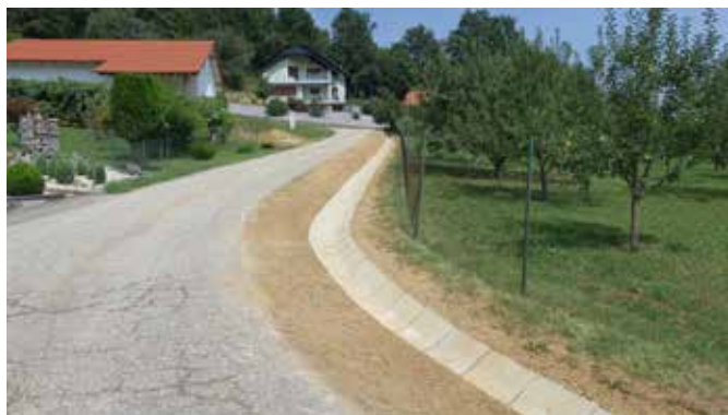
Ureditev odvodnjavanja s kanaletami nad igriščem pri Gradu (Foto: M. Žökš)
