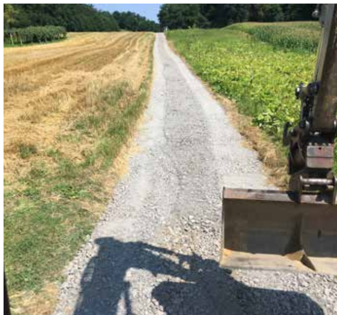
Po izvedbi (Foto: M. Žokš)
