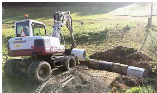
Razširitev propusta (Foto: M. Žökš)
